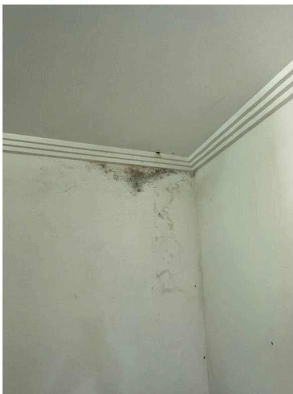
Fotografia 4. Marcação 1.3 - Infiltração na parede da biblioteca.
