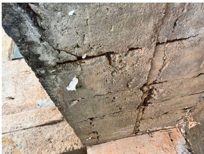
Fotografia 40. Marcação 3.6 a 3.8 - Corrosão de armaduras no subsolo (Vista inferior).
