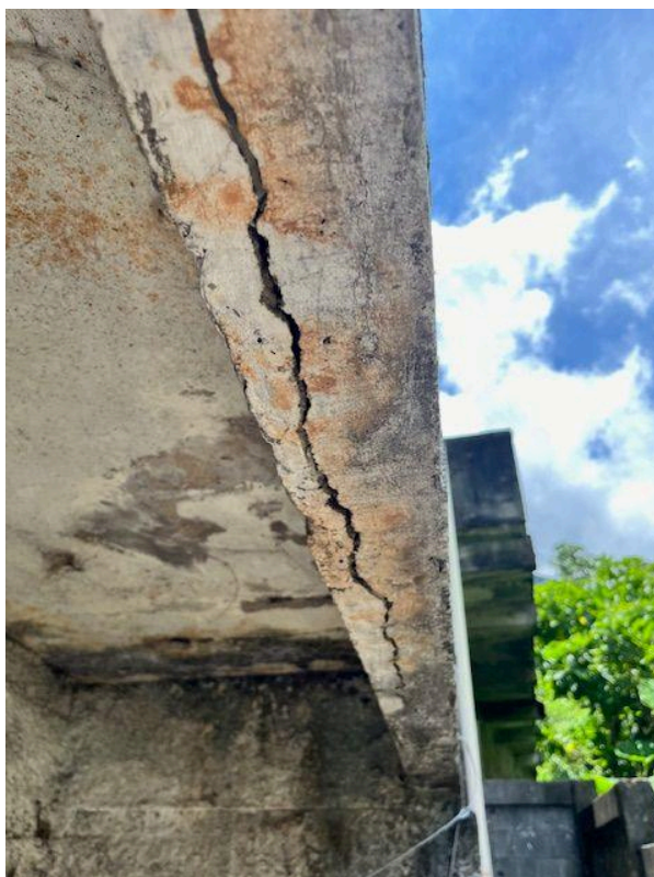
Fotografia 42. Marcação 3.8 e 3.9 - Corrosão de armaduras em vigas do subsolo (Vista superior).
