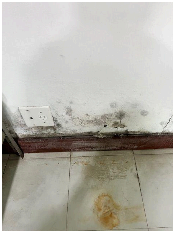
Fotografia 3. Marcação 1.3 e 2.2 - Infiltração e fissuras na parede da biblioteca.
