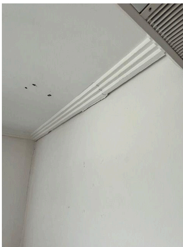
Fotografia 7. Marcação 2.3 - Abertura em junta de dilatação do forro de gesso do laboratório de informática.
