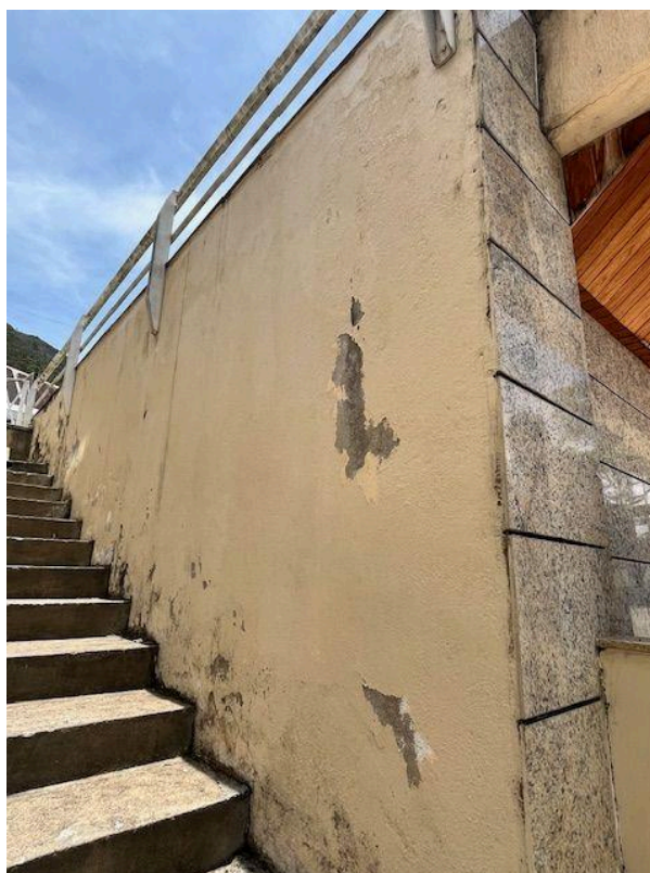
Fotografia 11. Falha no revestimento e pintura da fachada externa.
