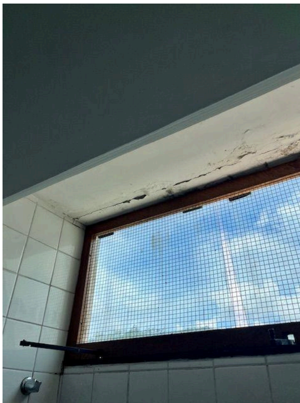
Fotografia 18. Marcação 2.8 - Trincas em forro de gesso dos banheiros.
