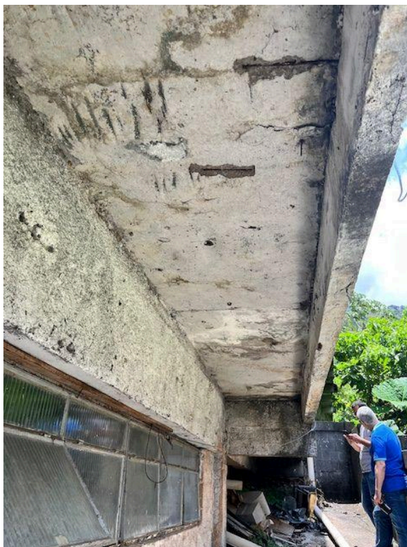
Fotografia 37. Marcação 3.3 e 3.4 - Corrosão de armaduras em lajes e vigas do subsolo.
