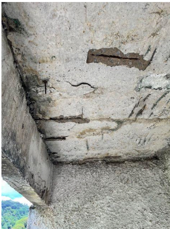
Fotografia 39. Marcação 3.6 a 3.8 - Corrosão de armaduras em lajes do subsolo (Vista superior).
