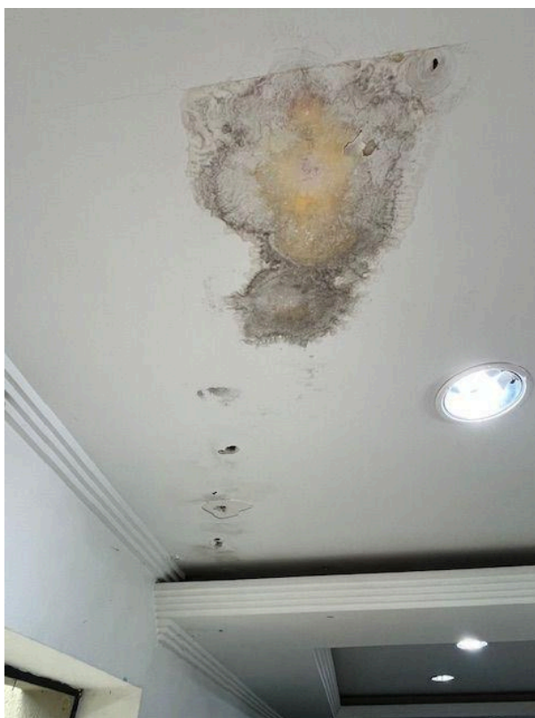
Fotografia 2. Marcação 1.2 - Infiltração em forro de gesso da biblioteca.
