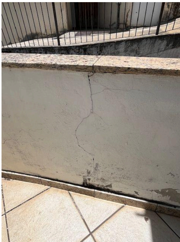
Fotografia 12. Marcação 2.6 - Fissuras em alvenaria de platibanda externa.
