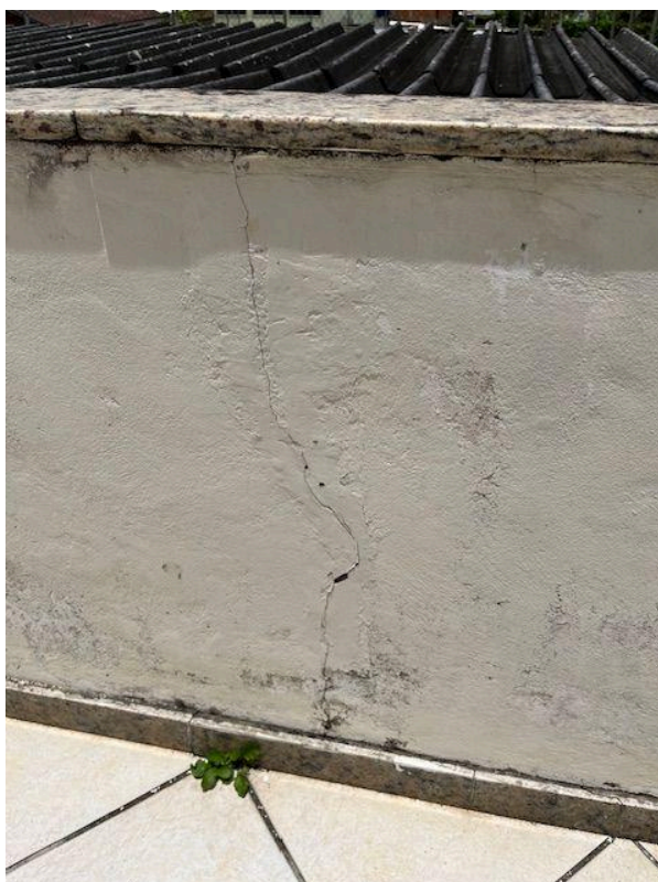
Fotografia 25. Marcação 2.14 - Fissuras em alvenaria de platibanda externa.
