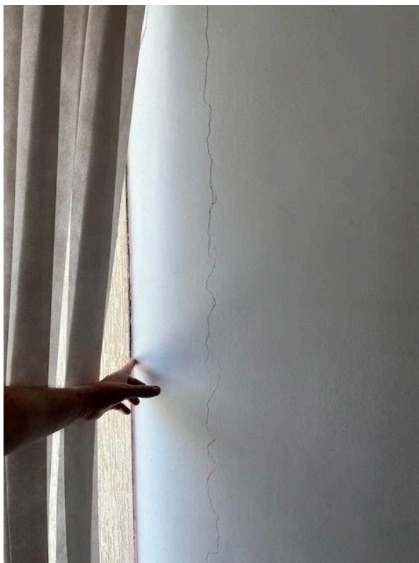
Fotografia 14. Marcação 2.7 - Trinca vertical na parede próximo ao pilar.
