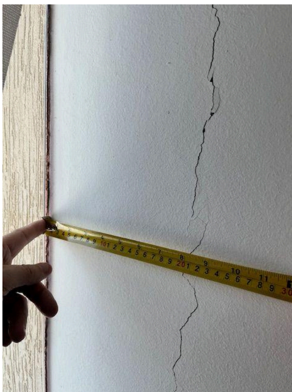
Fotografia 15. Marcação 2.7 - Medição da distância do pilar até a trinca vertical na parede.
