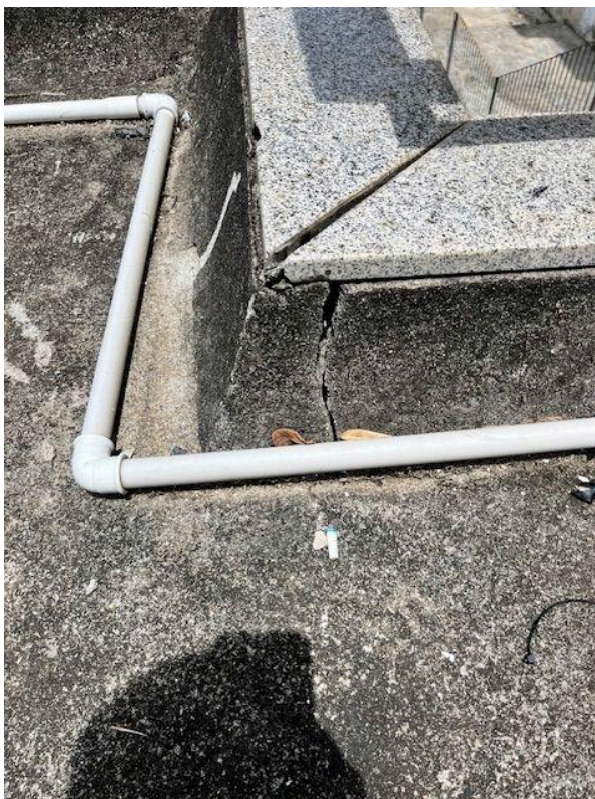
Fotografia 30. Trincas em proteção mecânica da cobertura.
