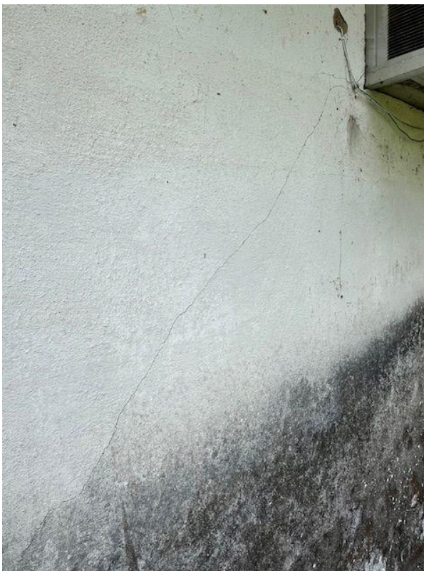
Fotografia 23. Marcação 2.12 - Fissura inclinada em 45° na parede externa da sala de estudos 1.
