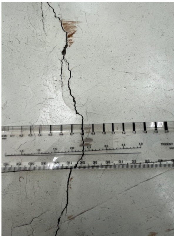
Fotografia 8. Marcação 2.4 - Trincas no piso do laboratório de informática.
