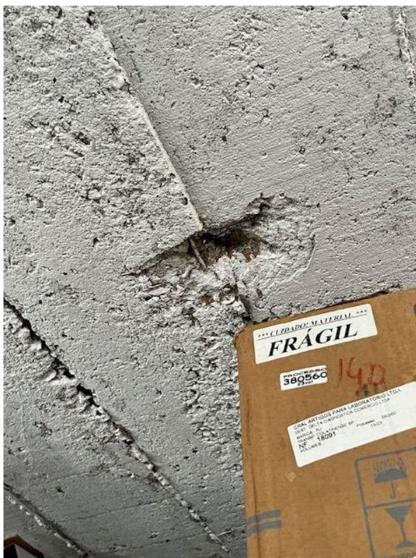
Fotografia 34. Marcação 3.2 - Corrosão de armaduras em laje do subsolo.
