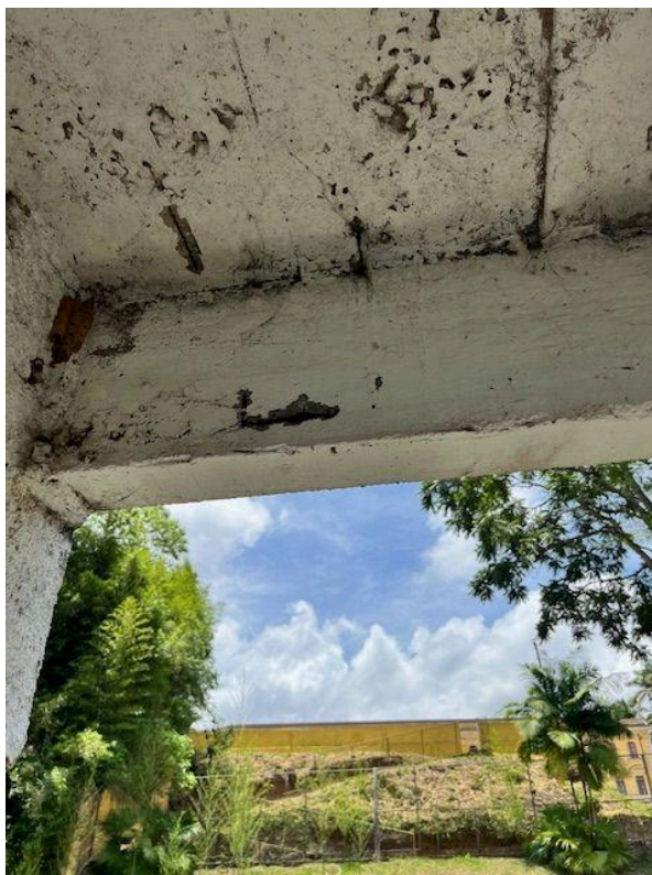
Fotografia 35. Marcação 3.3 - Corrosão de armaduras em lajes e vigas do subsolo.
