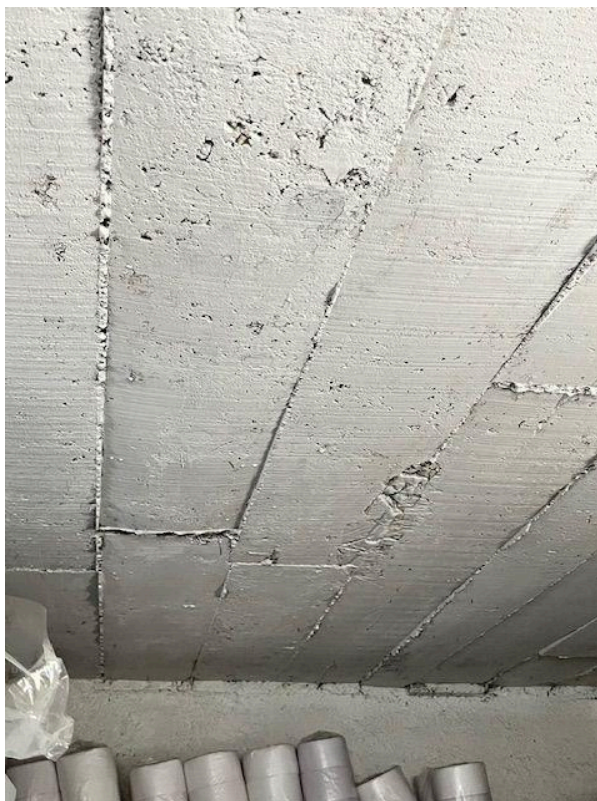
Fotografia 33. Marcação 3.2 - Corrosão de armaduras em laje do subsolo.
