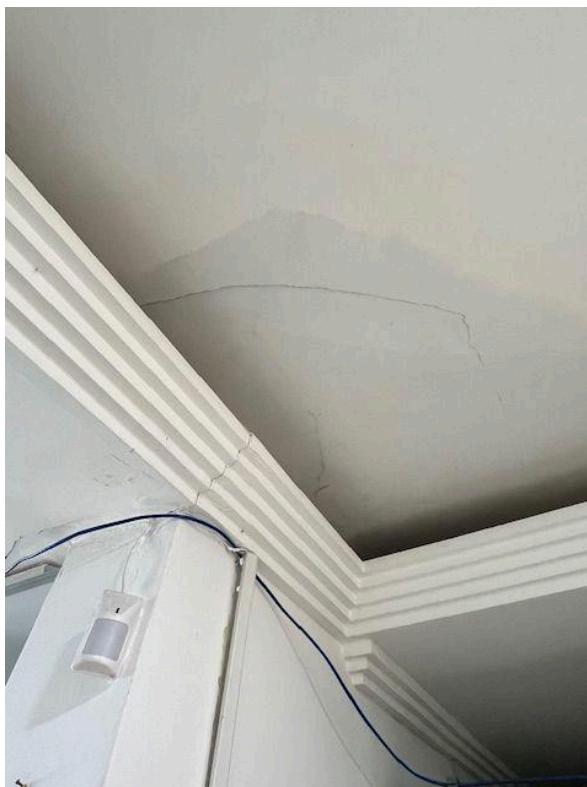
Fotografia 1. Marcação 1.1 - Infiltração no gesso e aberturas em junta de dilatação do forro de gesso.
