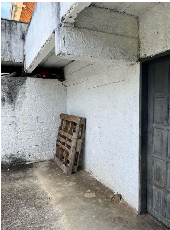
Fotografia 27. Marcação 2.15 - Fissura na parede externa do subsolo.
