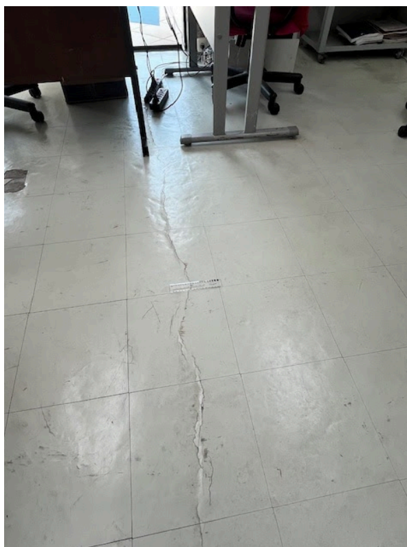
Fotografia 9 . Marcação 2.4 - Trincas no piso do Laboratório de Informática.
