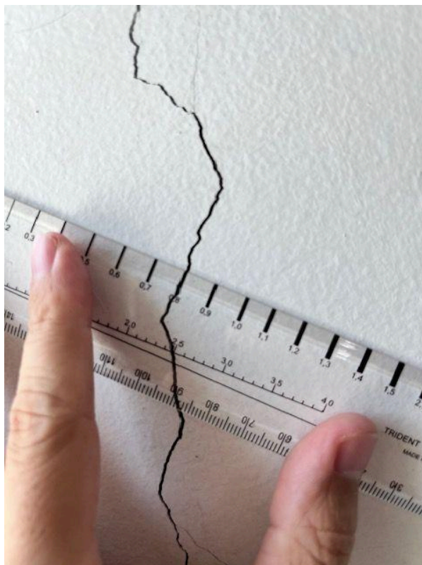
Fotografia 20. Marcação 2.9 e 2.10 - Medição com fissurômetro de trinca na parede.
