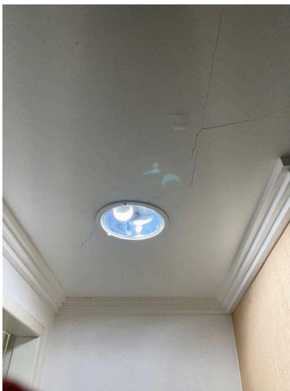
Fotografia 13. Próximo da Marcação 2.7 - Trincas no forro de gesso.
